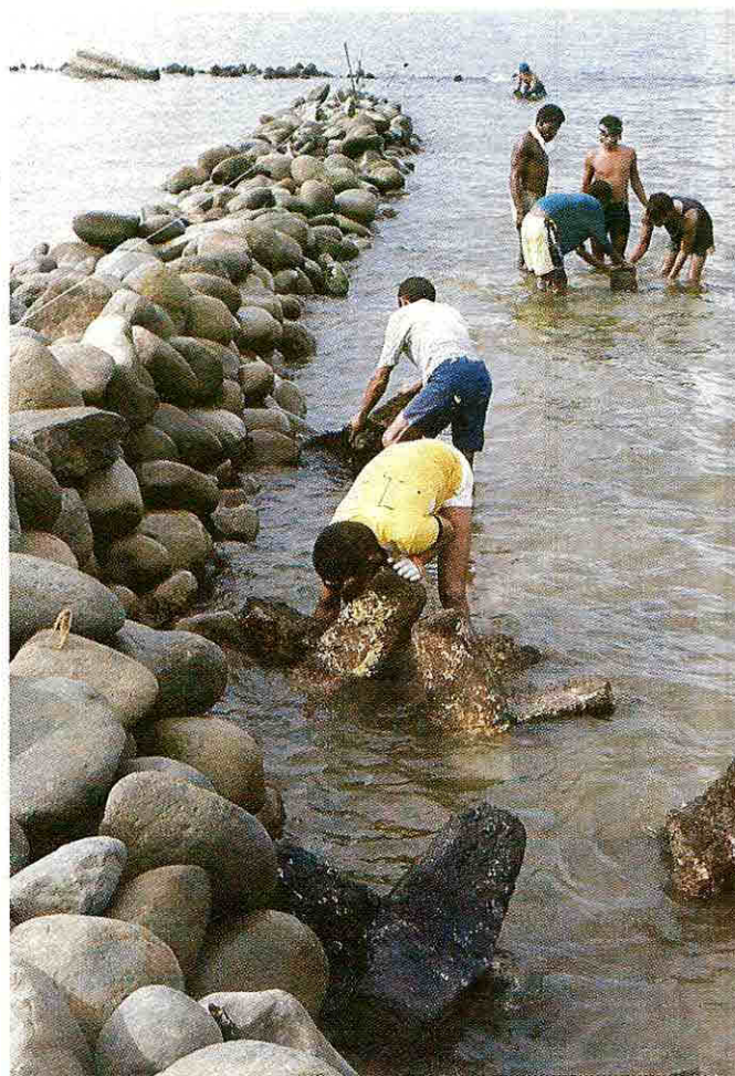
Foto 4. Movimiento manual del material de roca durante la ejecución de las obras de defensa en el Apostadero Naval de Turbo.
