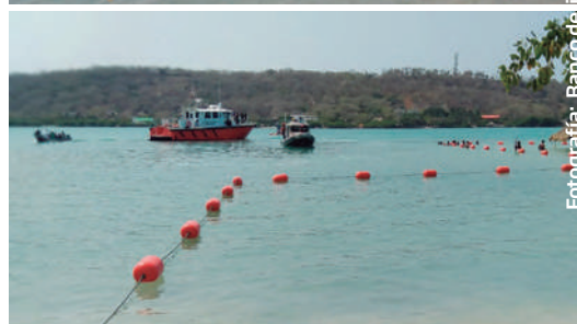
Paralelo del antes y el después de la instalación de la zonificación de la zona de bañistas playa Cholón, Islas del Rosario.
