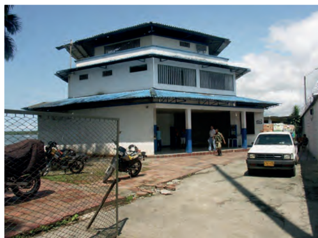
Edificio de La Pagoda, donde funcionaban algunas oficinas de la Capitanía de Puerto. Este edificio fue reemplazado por el actual en el año 2012.
