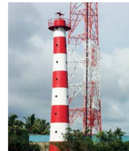
Figura 5. Proceso constructivo, transporte, ensamble y puesta en funcionamiento del Faro de Pizarro, en PRFV.
