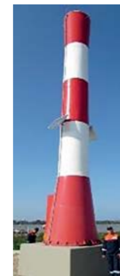
Figura 10. Torre de enfilación E18 - Canal Barranquilla.
