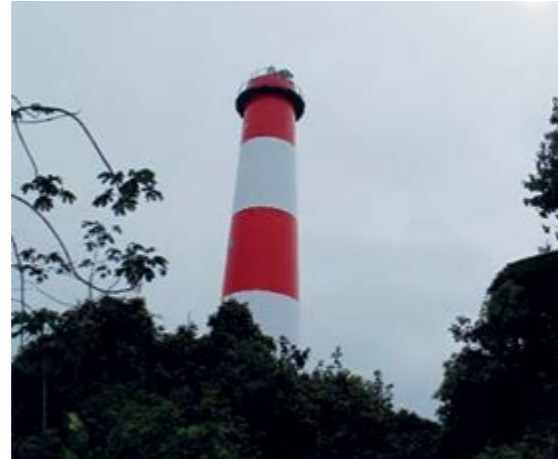
Figura 7. Faro antiguo y construido en Isla Palma: Faro construido en Isla Palma, de características estructurales especiales, de 42 metros de altura, con estructura metálica principal y estructura con adecuación de mampostería. Fuente Dimar.
