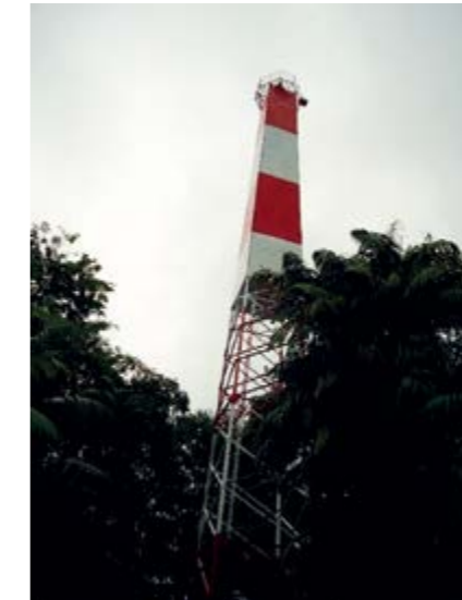
Figura 9. Vista del faro antiguo y construido en Cabo Marzo: 2. Estructura metálica construida de 40 metros de altura, recubierta con láminas metálicas para darle visibilidad diurna. El recubrimiento cuenta con perforaciones para reducir el efecto del viento en la estabilidad de la estructura. Fuente Dimar.
