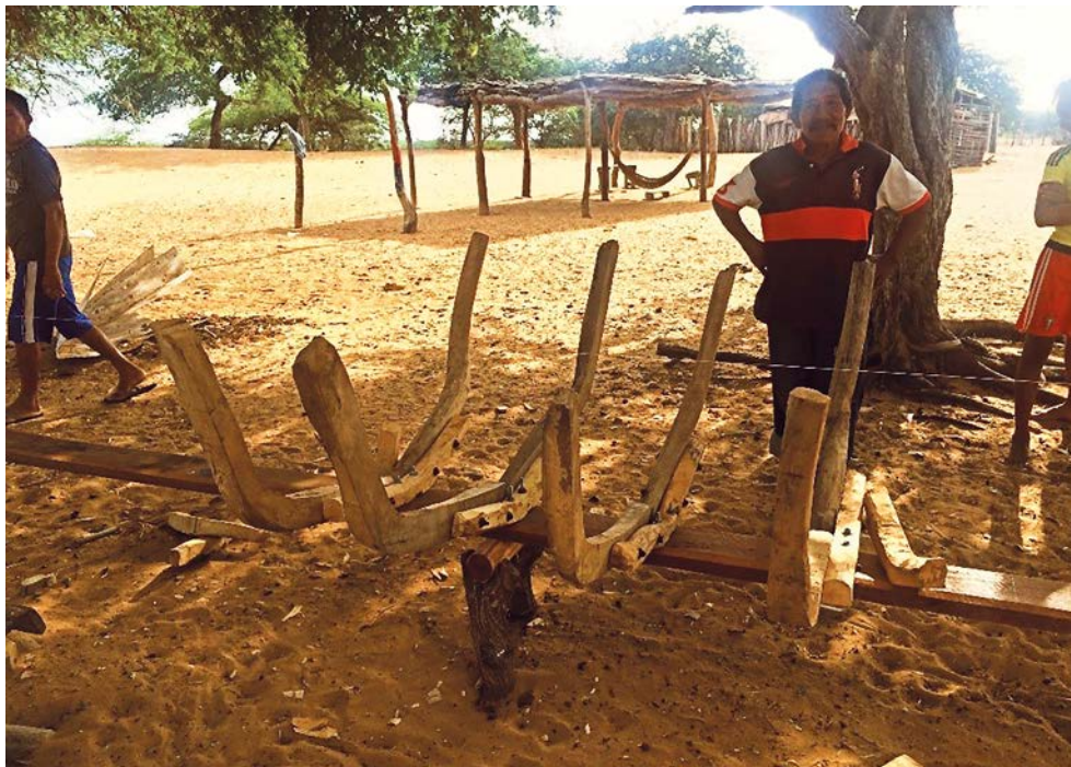
Figura 2. Constructor naval Wayúu.
