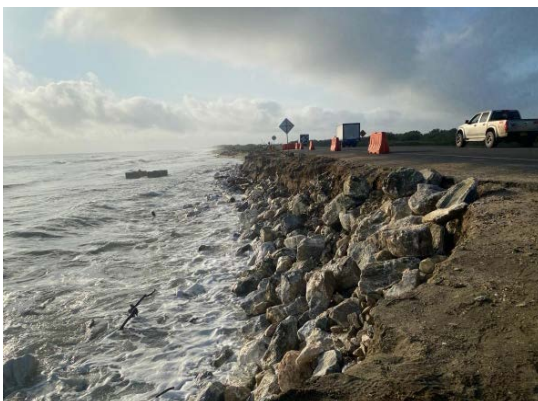
↑ Procesos de erosión que afectan el Km 19 vía Santa Marta.
