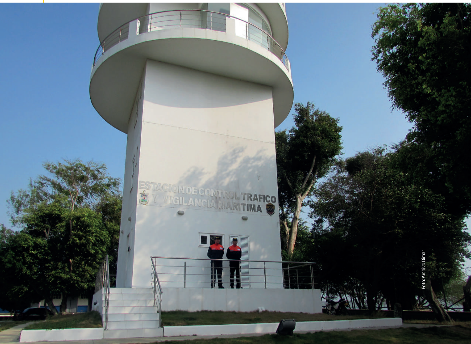
Torre de Control Tráfico Marítimo de Turbo.
